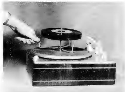
Bild 4. Ein Plattenstapel wurde eben aufgesetzt, die Gabel wird nach unten und dann seitlich weggezogen
